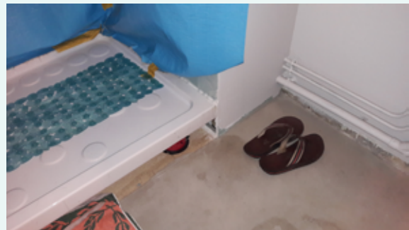
9. Utilisation inadéquate d'une douche inachevée (absence de tablier en partie basse, de pare-douche et de tapis) (© SOCABAT)
