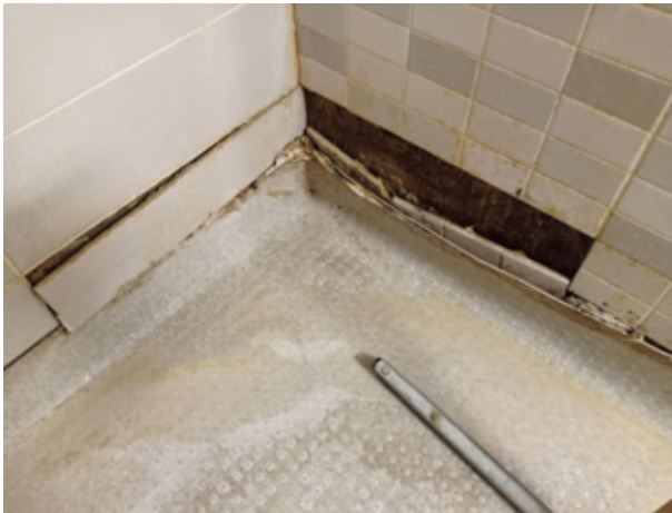
7. Défaut de raccordement entre sol et paroi murale d'une douche sans receveur (© SOCABAT)
