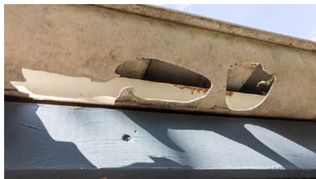
Gouttière en PVC impactée par la grêle © sylv1rob1 - Shutterstock
