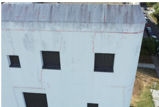
▲ Exemple de détection de fissure par l'IA ©Lynxdrone
