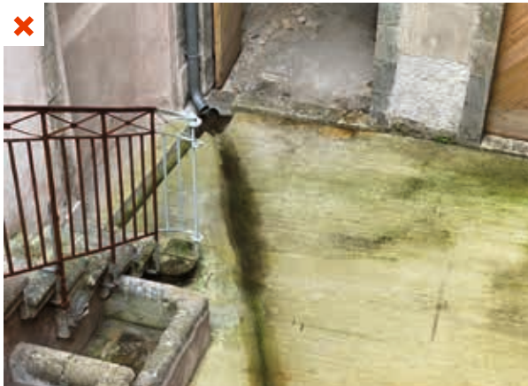
Le cheminement initial des eaux pluviales a été modifié et la bouche d'évacuation mise en place est sous-dimensionnée. ©AQC
