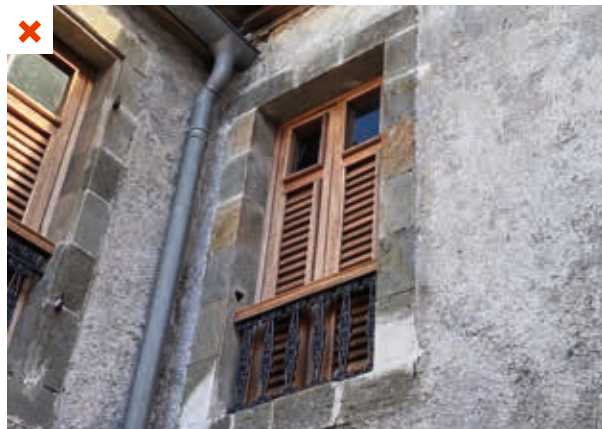
Le garde-corps, nouvellement installé, ne respecte pas les dimensions d'origine. Par ailleurs, le dimensionnement ne répond pas aux normes en vigueur en matière de sécurité (MHI).
