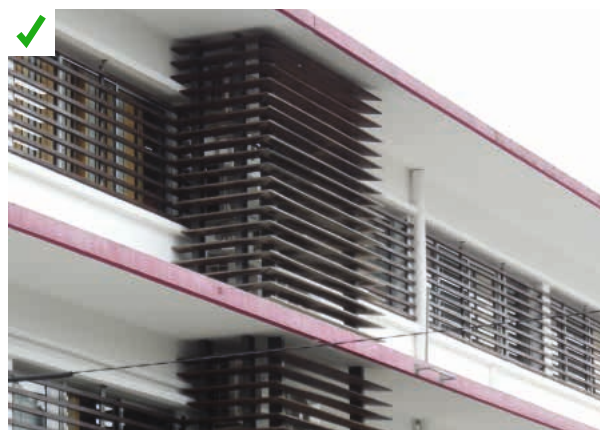
Emplacements dédiés en façade pour les unités extérieures de climatiseurs avec des protections adaptées et une circulation d'air suffisante. ©AQC
