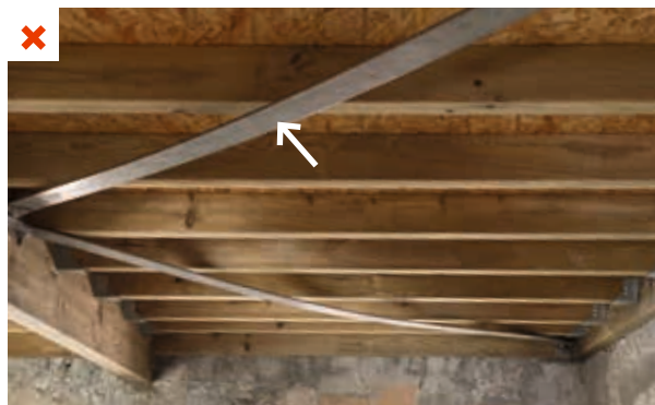
Compression anormale des éléments de contreventement. ©AQC
