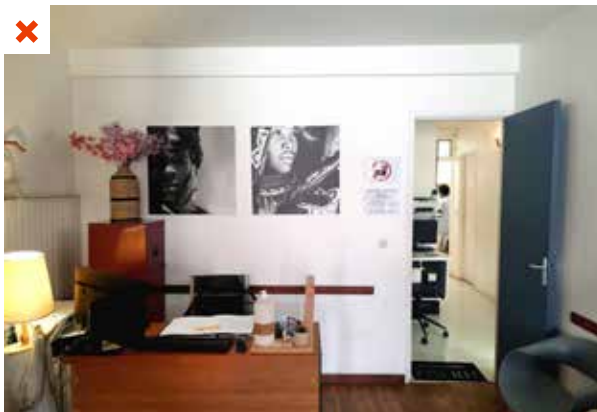
La pose d'une cloison pour délimiter les pièces empêche la ventilation traversante. ©AQC
