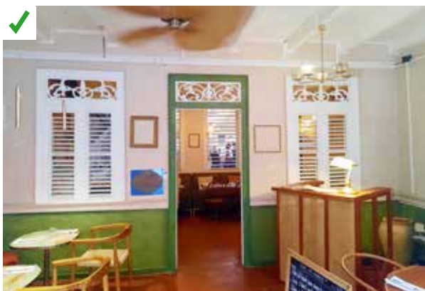
Dans les maisons traditionnelles créoles, si les pièces sont délimitées par des étraves et des menuiseries, des impostes et des jalousies favorisent la ventilation traversante. ©AQC
