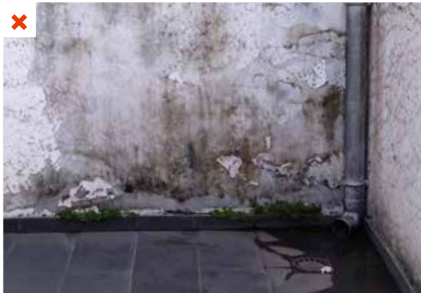
L'évacuation des eaux pluviales du patio n'est pas complète. L'eau stagne dans le coin du fait d'un défaut de pente. ©AQC
