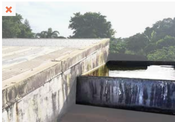
Le réservoir d'eau est exposé aux intempéries et apports directs de feuilles mortes, ce qui peut obstruer le circuit d'alimentation. De plus, l'eau peut être contaminée par des virus. ©AQC
