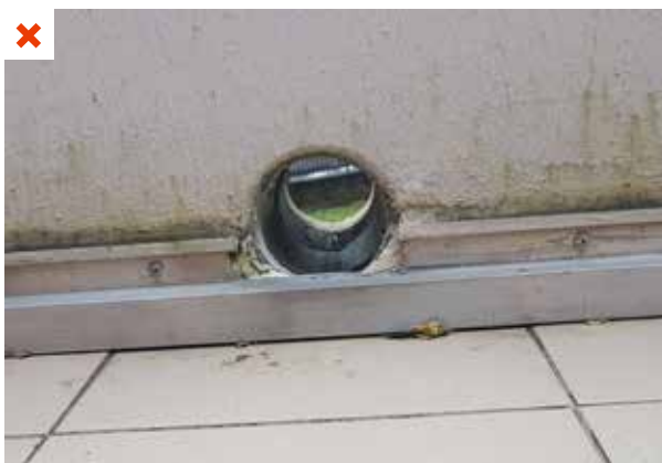
La pissette des eaux pluviales de la terrasse n'est pas au niveau du sol fini et est obturée. ©AQC
