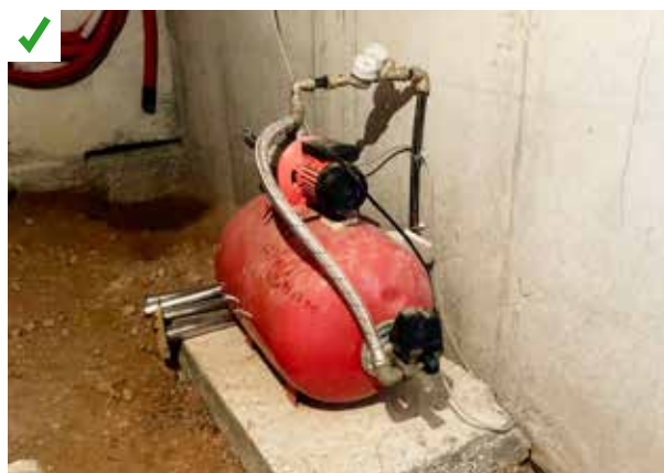
Implantation d'un surpresseur avec filtre, afin d'éviter toute contamination, pour usage vers les WC et le lave-linge. ©AQC
