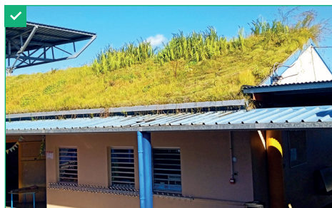
Mise en œuvre de modules végétalisés préfabriqués en surimposition d'une toiture en bac acier. © AQC
