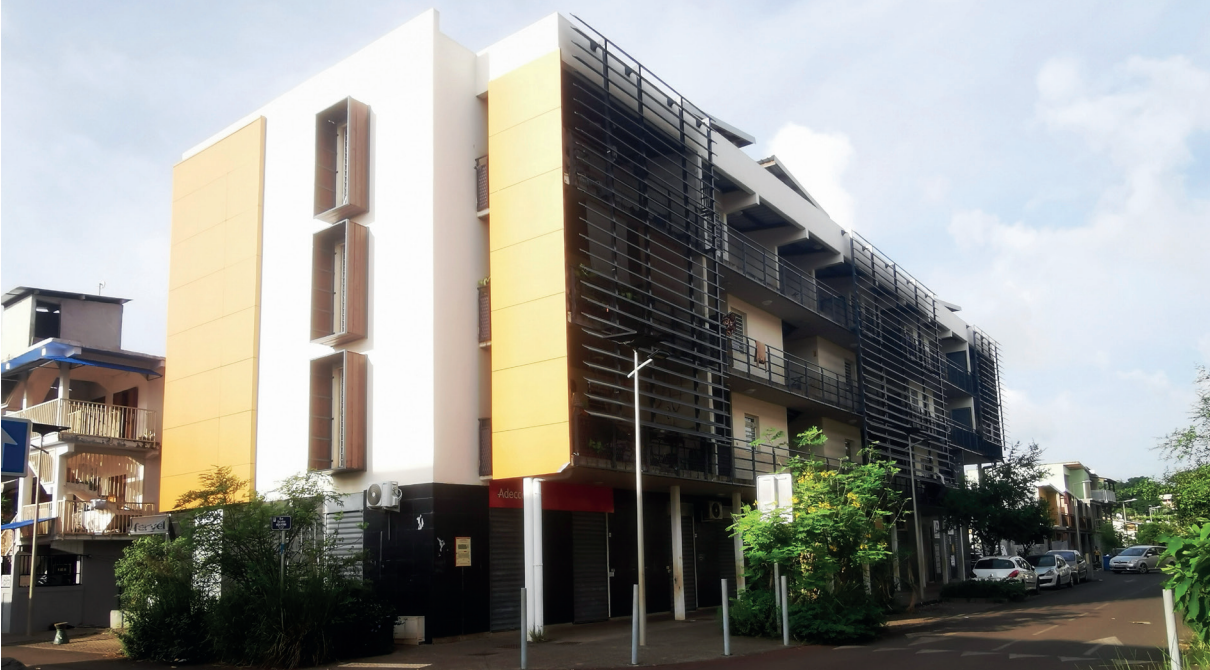
Logement collectif - Mayotte (Mamoudzou)
