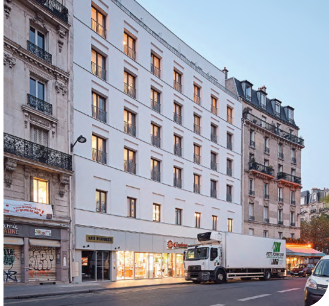
Réalisée par les agences Architecture Pélegrin et JBMN Architectes pour Linkcity (Bouygues Construction), cette surélévation a permis la création de 1100 m 2 de surface de plancher sur 5 niveaux, au-dessus d'un supermarché, place de la Nation à Paris. © Jérôme Epailard-JBMN Architectes&Architecture Pélegrin
