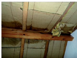
Exemple de condensation au travers de la paroi (photos prises après démontage des lambris). Photo © 2015 – Mathieu Cortal – AQC (absence de pare-vapeur intérieur)
