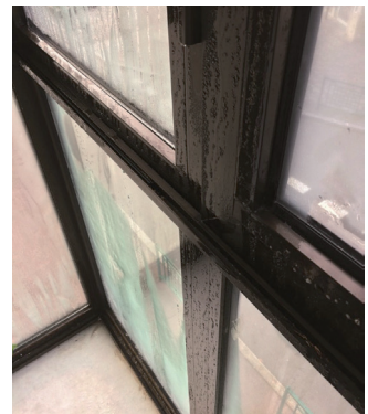
Exemple de condensation au niveau d'une menuiserie. Photo © 2017 - Erwan Bidan - AQC
